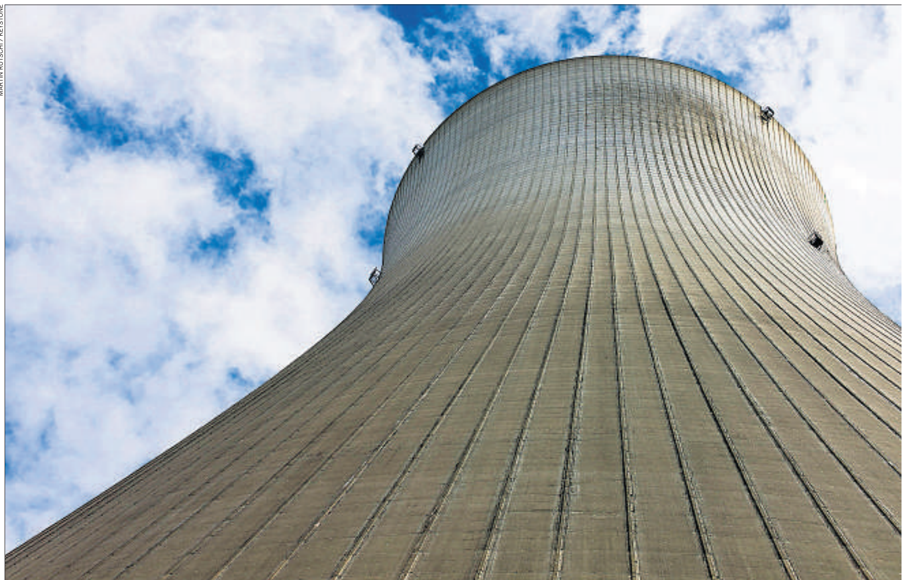
Der Kühlturm des AKW Leibstadt (August 2010). Die Schweizer AKW-Betreiber müssen neu aufzeigen, wie es um die Kühsicherheit der Lagerbecken für Brennelemente steht.
